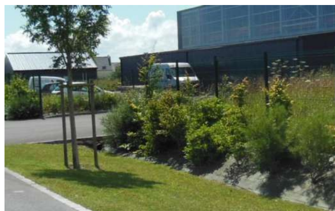
Figure 9 – Illustration d'une noue dissymétrique
